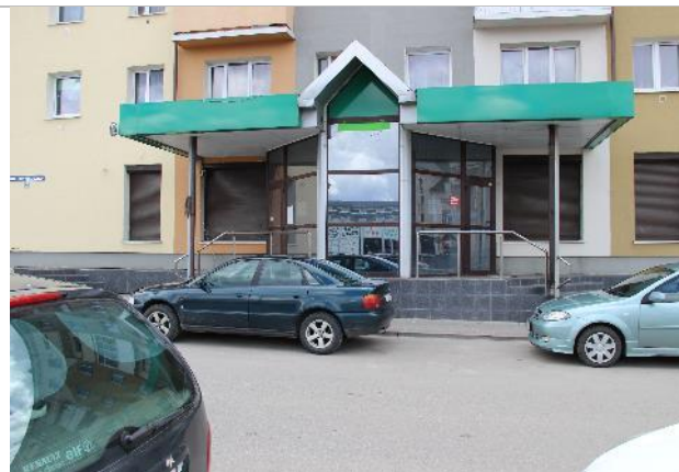
Фотография 3.1. Внешнее состояние объекта
