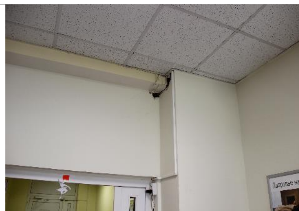
Фото 5. Внутреннее состояние объекта
