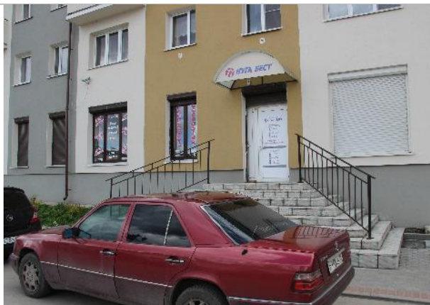
Фотография 3.2. Внешнее состояние объекта
